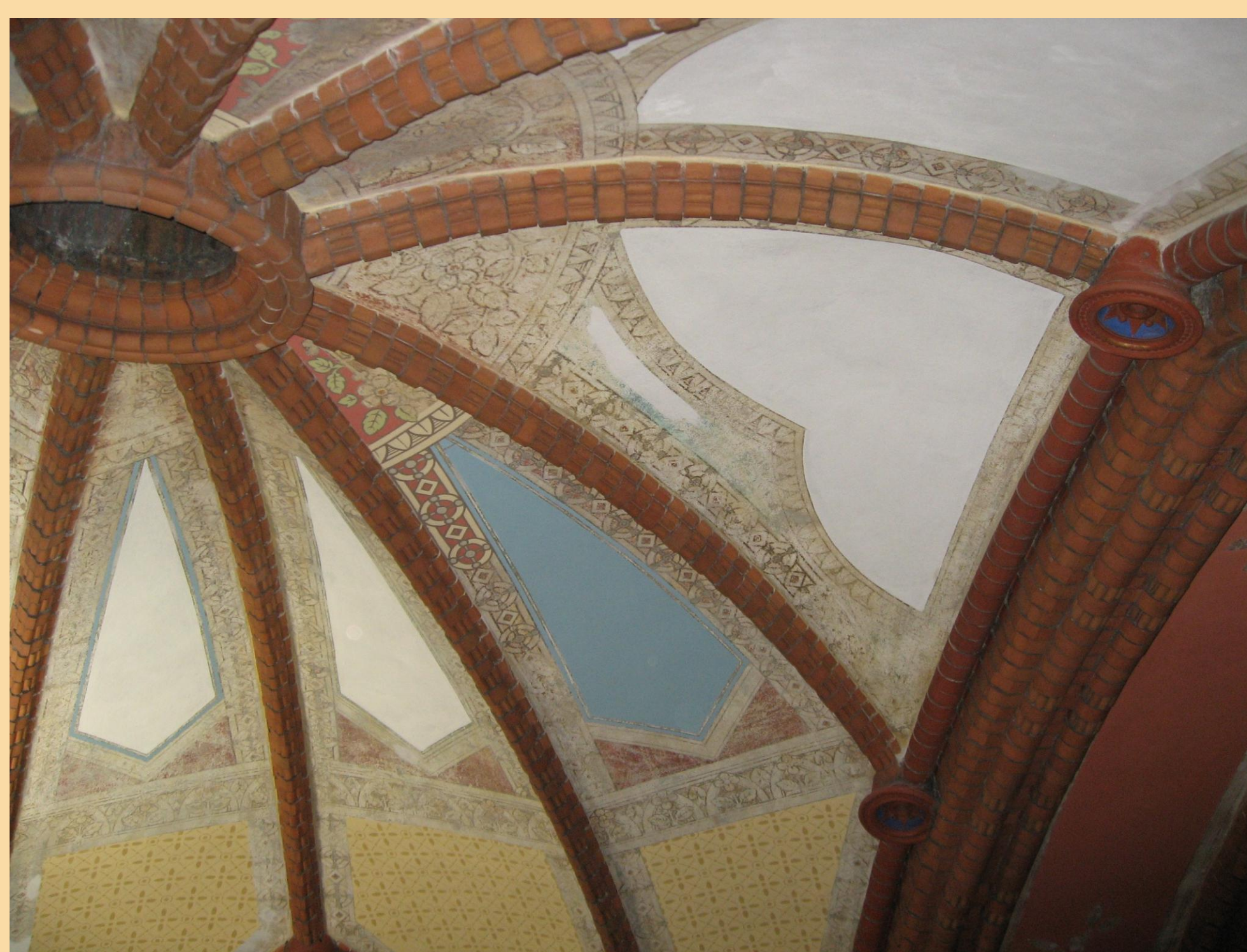
Die Altarraumkuppel während der Restaurierung
