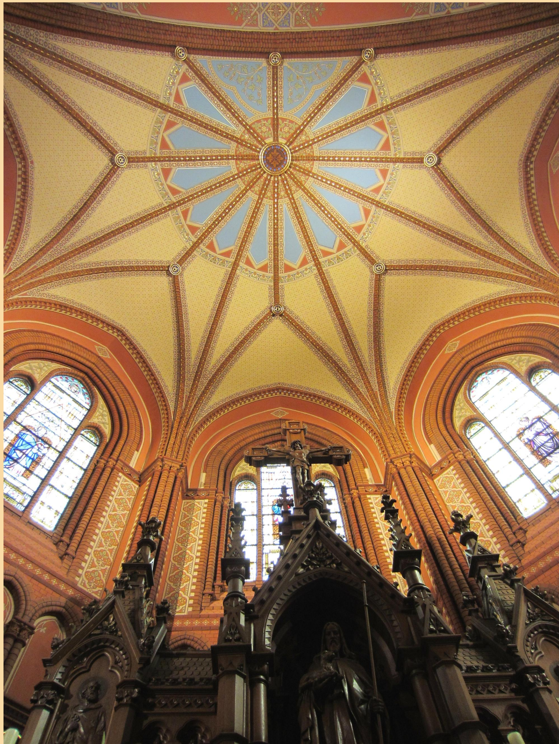
Nach dem Abbau des Gerüstes war die Gemeinde überwältigt von der Schönheit des Altarraums.
